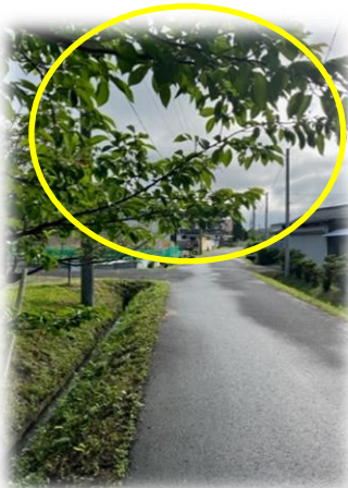
道に張り出した枝
